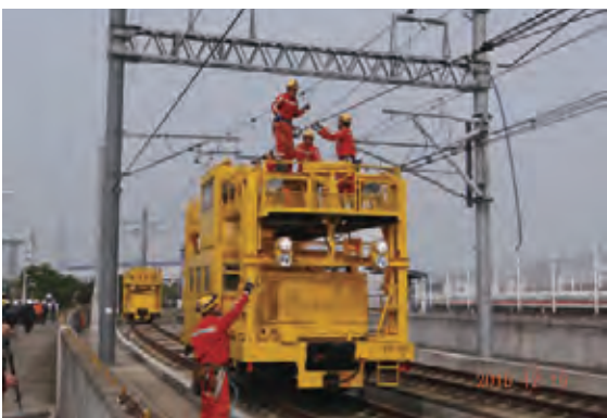
接觸線斷線復舊作業
