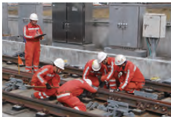
BWG 道岔液壓扣拉裝置拆裝作業
