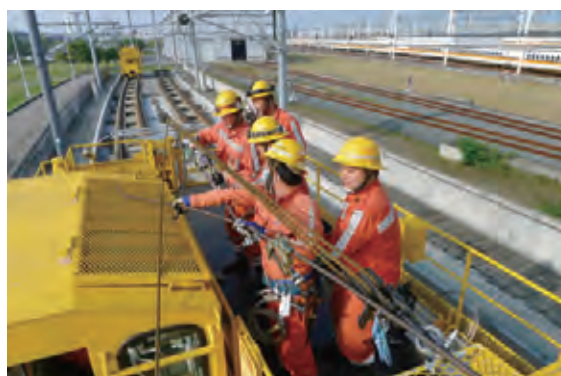
電車線專業訓練 – 電車線更換訓練
