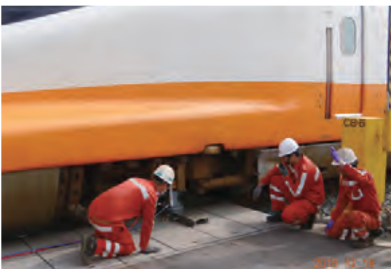
車輪駛運器裝設作業
