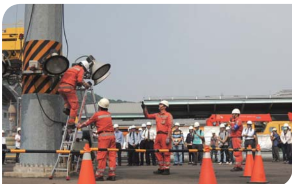
基地高空作業維修訓練
