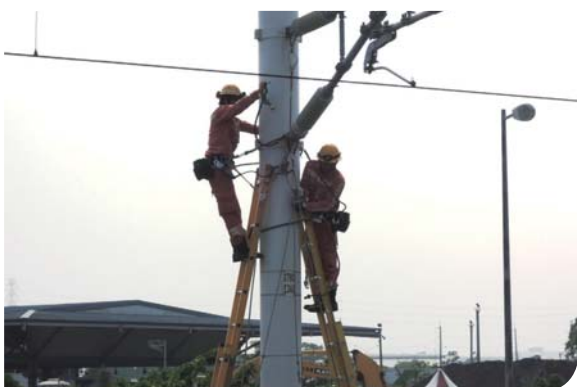
電車線復舊訓練
