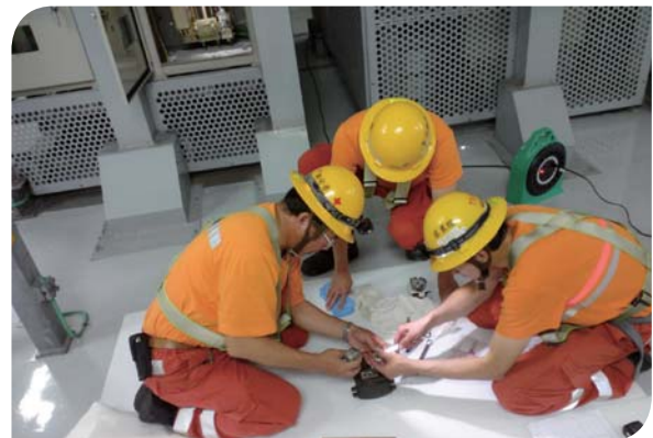
電力專業訓練 - 油壓錶故障更換
