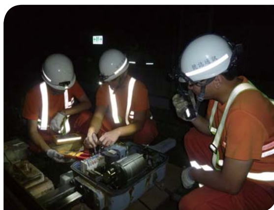
號誌專業訓練 – 道岔維修訓練
