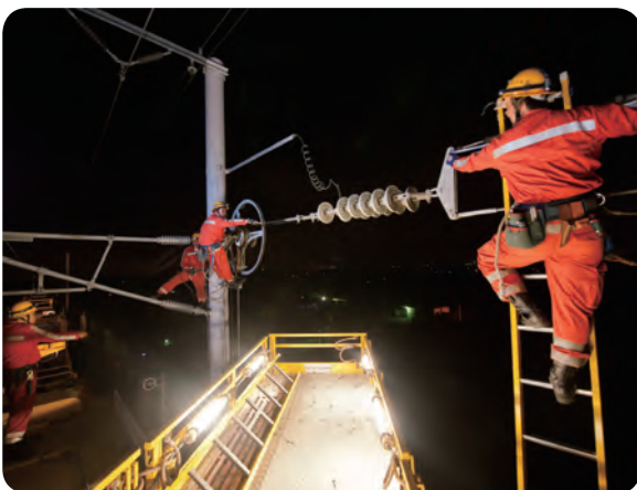
電車線專業訓練-電車線檢查更換
