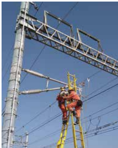
軌道電力部同仁執行電車線拉桿臂更換
