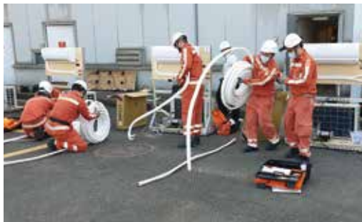
兩兩一組進行空調系統故障緊急更換
