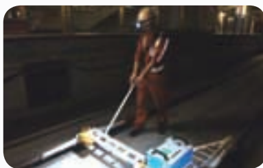
軌道專業訓練－鋼軌線型檢測作業
