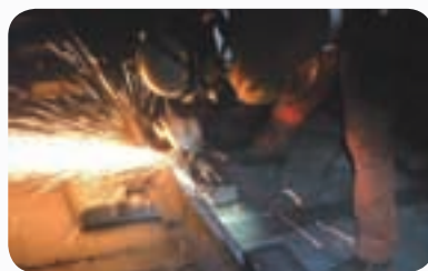
軌道專業訓練－鋼軌研磨作業
