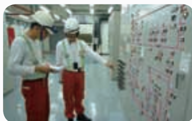
電力專業訓練-變電站例行檢查
