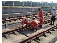
鋼軌緊急魚尾鉗安裝競賽
