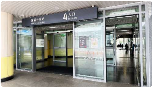
2025 年完成嘉義 / 台南站 1 號及 4 號出入口門扇自動化改善
