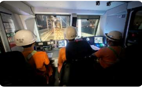
2025 年維護作業 - 軌道線形檢測、軌道光學檢測
