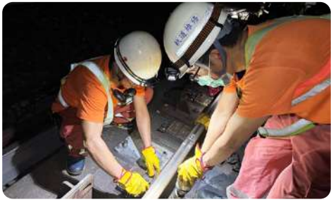
2025 年維護作業 - 夜間軌道維修
