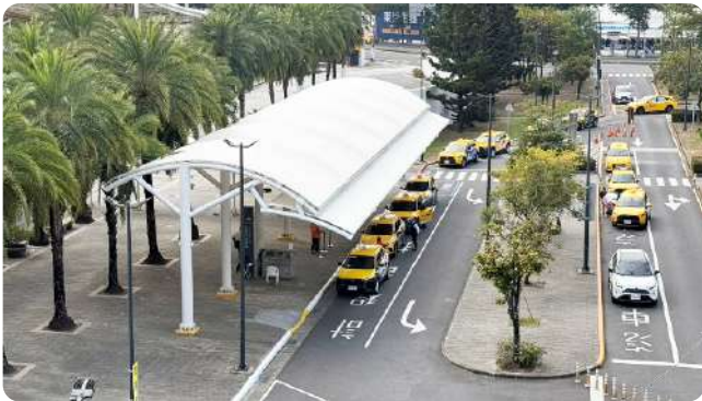
2025 年完成台南站排班計程車上客區雨遮工程改善
