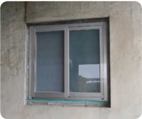
高速鐵路噪音自主性改善—換裝隔音窗
