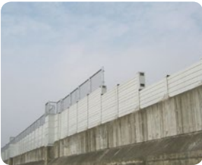
高速鐵路噪音自主性改善—增設隔音牆
