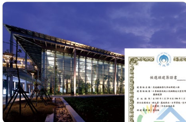
彰化站（姚仁喜 | 大元建築工場 提供 鄭錦銘攝）
