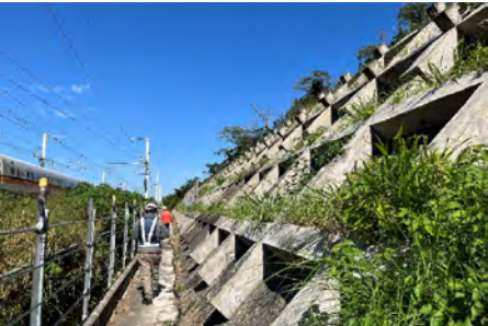
委託技師進行邊坡現場勘查
