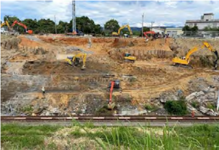
高鐵維修人員執行現場搶修工程
