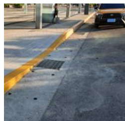
排班計程車乘車區增設斜坡
