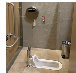
全線車站蹲式廁間加裝扶手
