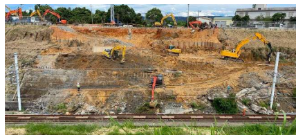
高鐵維修人員執行現場搶修工程
