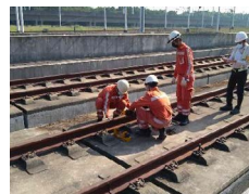
鋼軌緊急魚尾鉗安裝競賽
