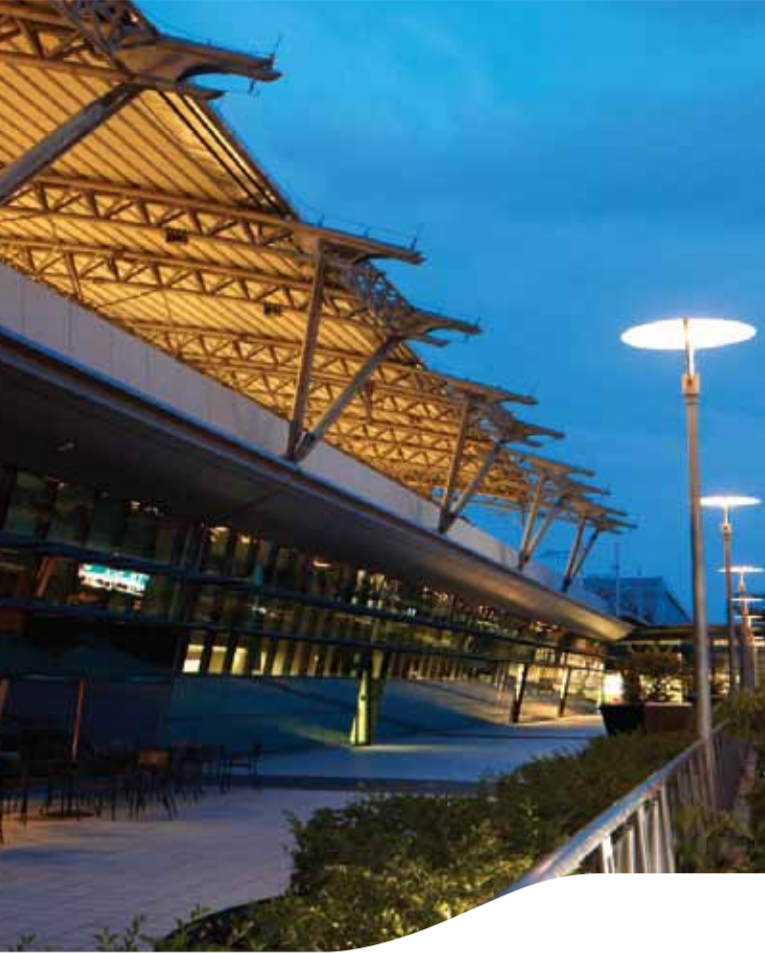
台中站 Taichung Station
